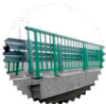
Перильные ограждения из композитов. Не требуют окраски, не подвержены коррозии.
