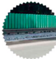
Противоослепляющие экраны предназначены для предотвращения ослепления водителей.
