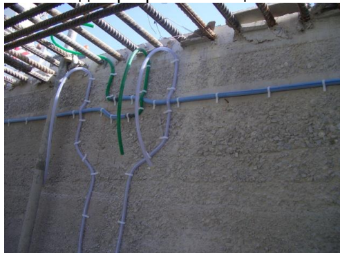
12. Метод перекрытия концов
