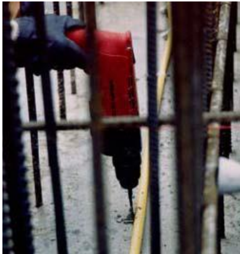
10. Сверловка отверстия для крепежей
